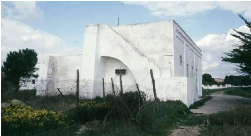
Masseria Galeota, prima della ristrutturazione
